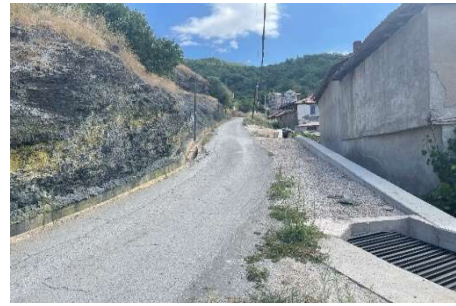
Слика бр.2 Изградба на атмосферска канализација и одводен канал
