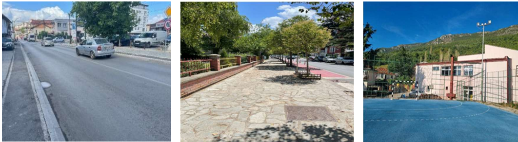
Слика бр.1 Изградба на општински патишта, тротоари и отворени игралишта
